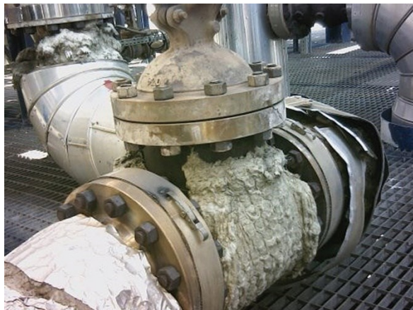
Figura 2.1. Instalación con aislamiento deteriorado y zonas sin aislar. Figura 2.2. Estudio termográfico de instalación.
