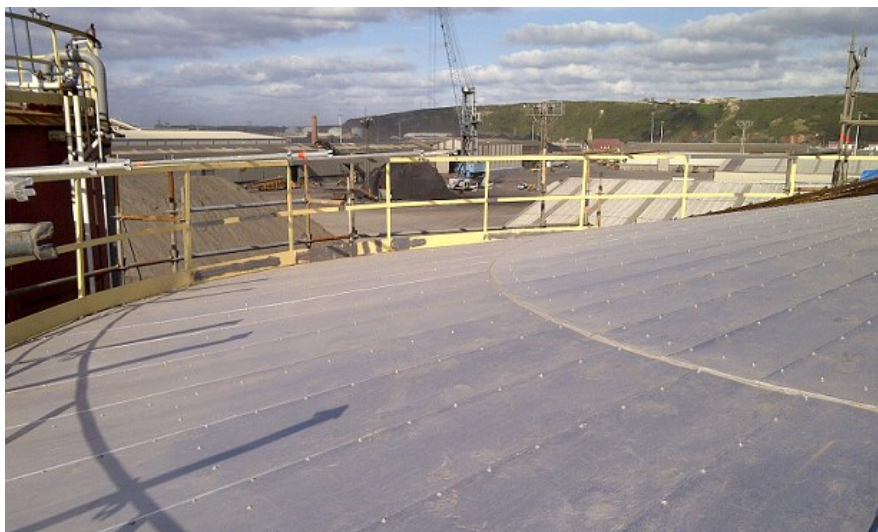
Figura 4.11.9. Ejemplo de aislamiento de techo.
