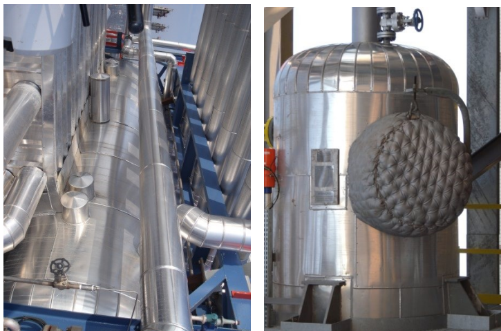
Figura 4.11.5. Ejemplo de ejecución de colchoneta para aislamiento con lana mineral
