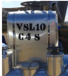
Figura 4.3.2.E Ejemplo de cajeadado metálico desmontable.
