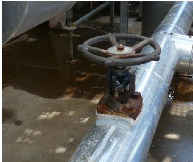
Figura 4.11.2 Ejemplo de ejecución de válvulas soldadas sin mantenimiento.
