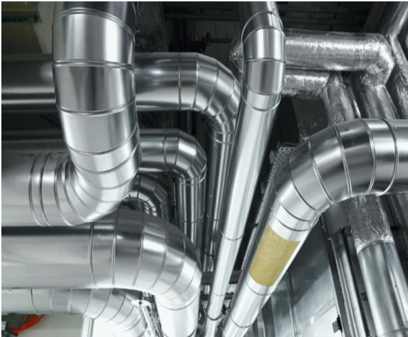
Figura 5.3. Instalación de tuberías
