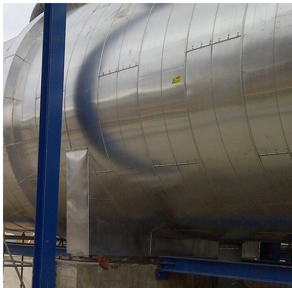
Figura 4.11.6. Ejemplo de ejecución de aislamiento de conservación de calor.
