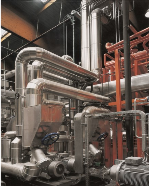
Figura 5.1. Instalación de tuberías en planta industrial
