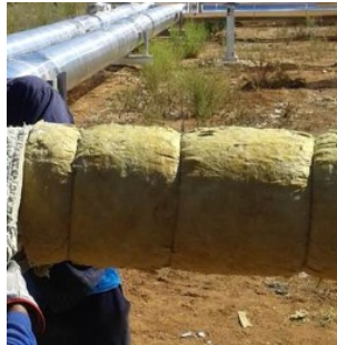
Figura 4.3.2.C Ejemplo de atado de coquilla con alambre
