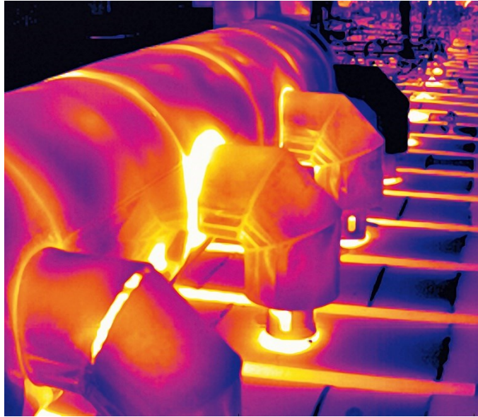
Figura 2.6. Estudio termográfico de un Proceso Industrial.
