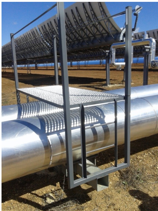
Figura 4.11.12. Ejemplo de plataforma de paso
