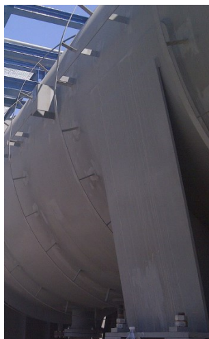
Figura 4.4.1.B Ejemplo de distanciador en equipo.
