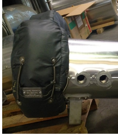
Figura 4.8.1. Ejemplo instalación de colchoneta en brida ciega.
