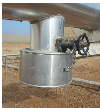
Figura 4.11.4. Ejemplo de ejecución de tapa de finalización de recubrimiento
