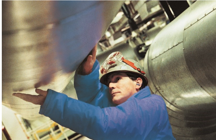
Figura 2.5. Inspección y mantenimiento en instalación industrial aislada.
