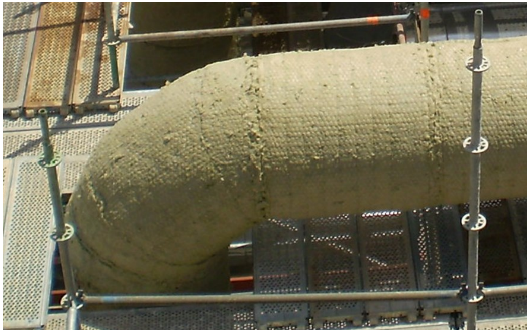
Figura 4.3.2.D Ejemplo de cosido de manta armada.
