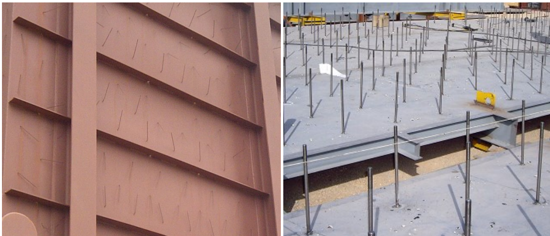
Figura 4.4.1.A Ejemplo de colocación de pinchos y pernos.
