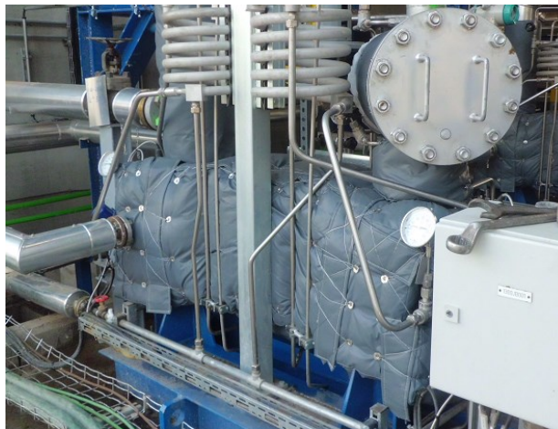
Figura 4.8.2. Ejemplo de colchoneta en una bomba.
